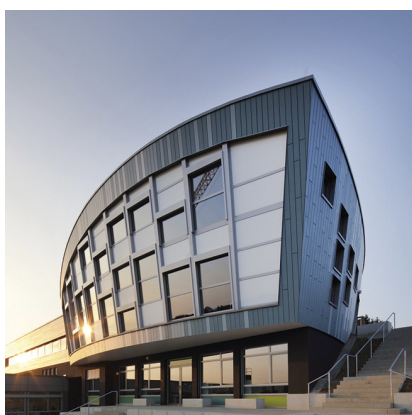
MÜHLBACHSCHULE SCHEMMERHOFEN BA 1+2+3 - HOLZBAU Erweiterung der Schule im Bestand Holzbau- und Fassadenarbeiten
