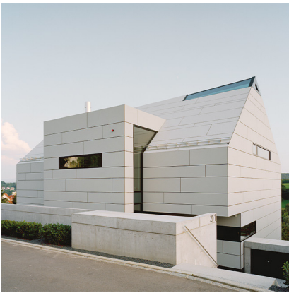
MEDER/PLANCK FASSADE DENKENDORF
