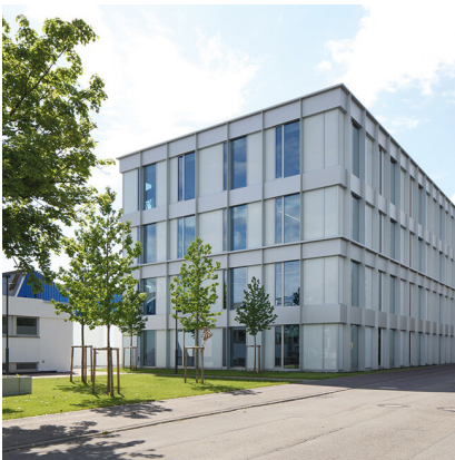
BÜROGEBÄUDE UHLMANN PAC-SYSTEME GMBH & CO. KG
