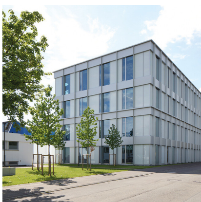
BÜROGEBÄUDE UHLMANN PAC-SYSTEME GMBH & CO. KG
