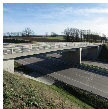
BRÜCKEN A8, BW 129
