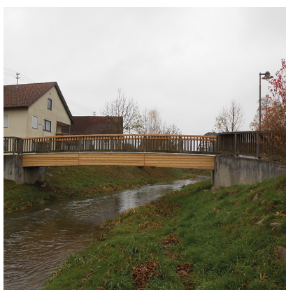
DÜRNACH HOLZBRÜCKE, BALTRINGEN
