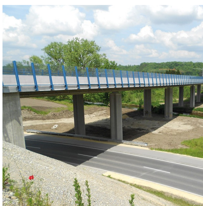
BRÜCKE BIBERACH NORDWESTUMFAHRUNG
