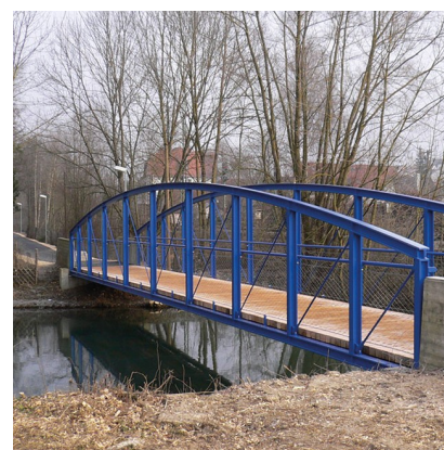
GEH- UND RADWEGBRÜCKE BLAUSTEIN-HERLINGEN, B28
